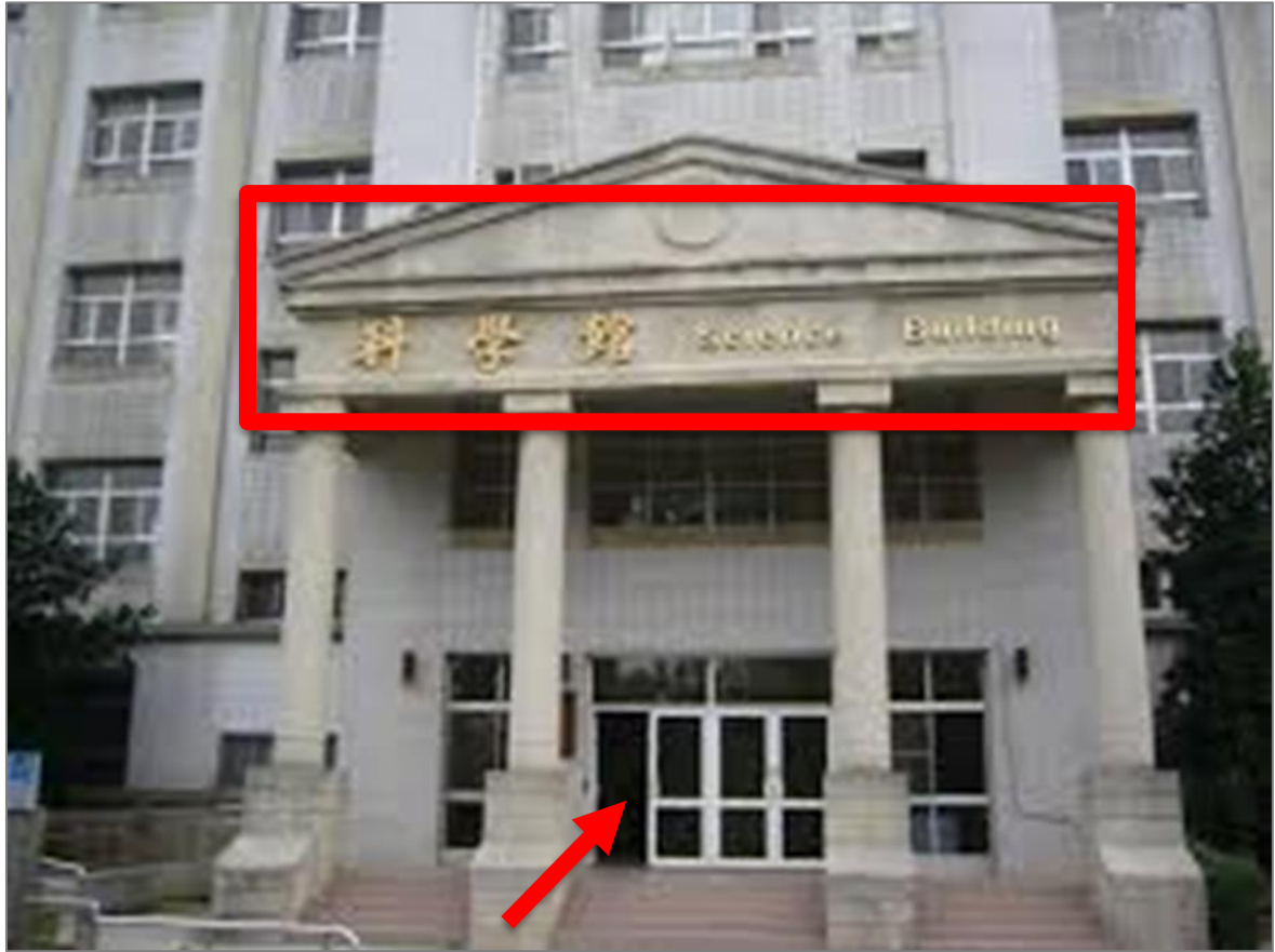
科學館正門一樓內左側 I109 教室
